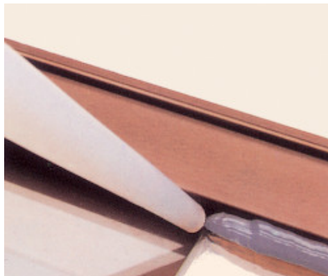
Σφράγιση με Mapesil AC ενός κουφώματος αλουμινίου
