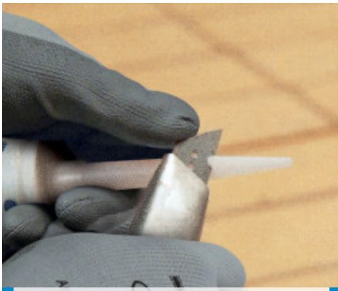
Κόψιμο του στομίου ώστε το άνοιγμα να ανταποκρίνεται στο μέγεθος του αρμού
